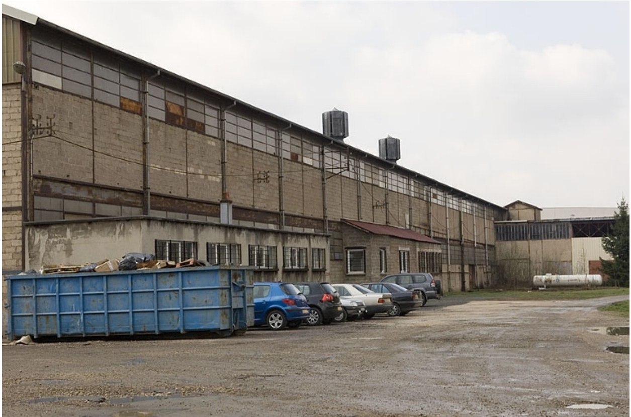
Façade nord de l'atelier de fabrication.
