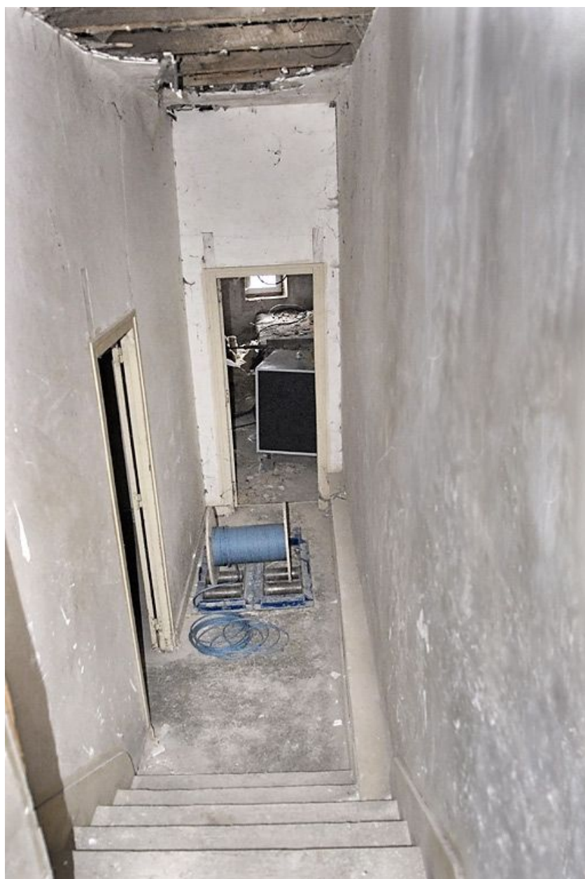
Couloir et escalier pendant les travaux.
