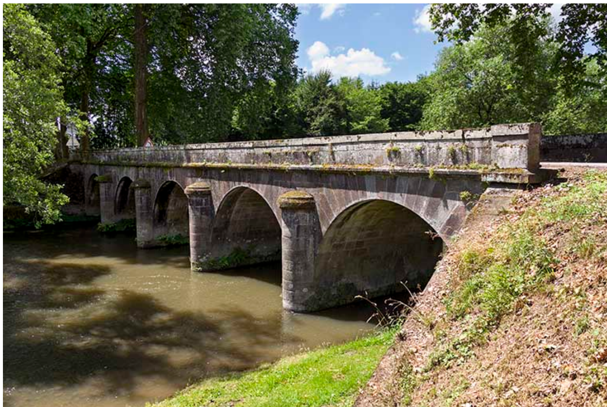
Vue du pont en amont.
