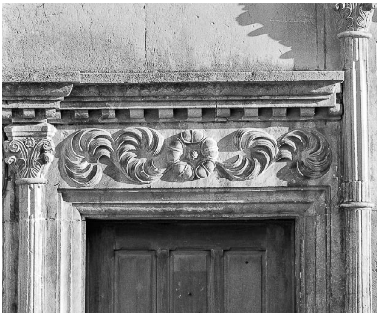
Linteau de fenêtre du rez-de-chaussée.
