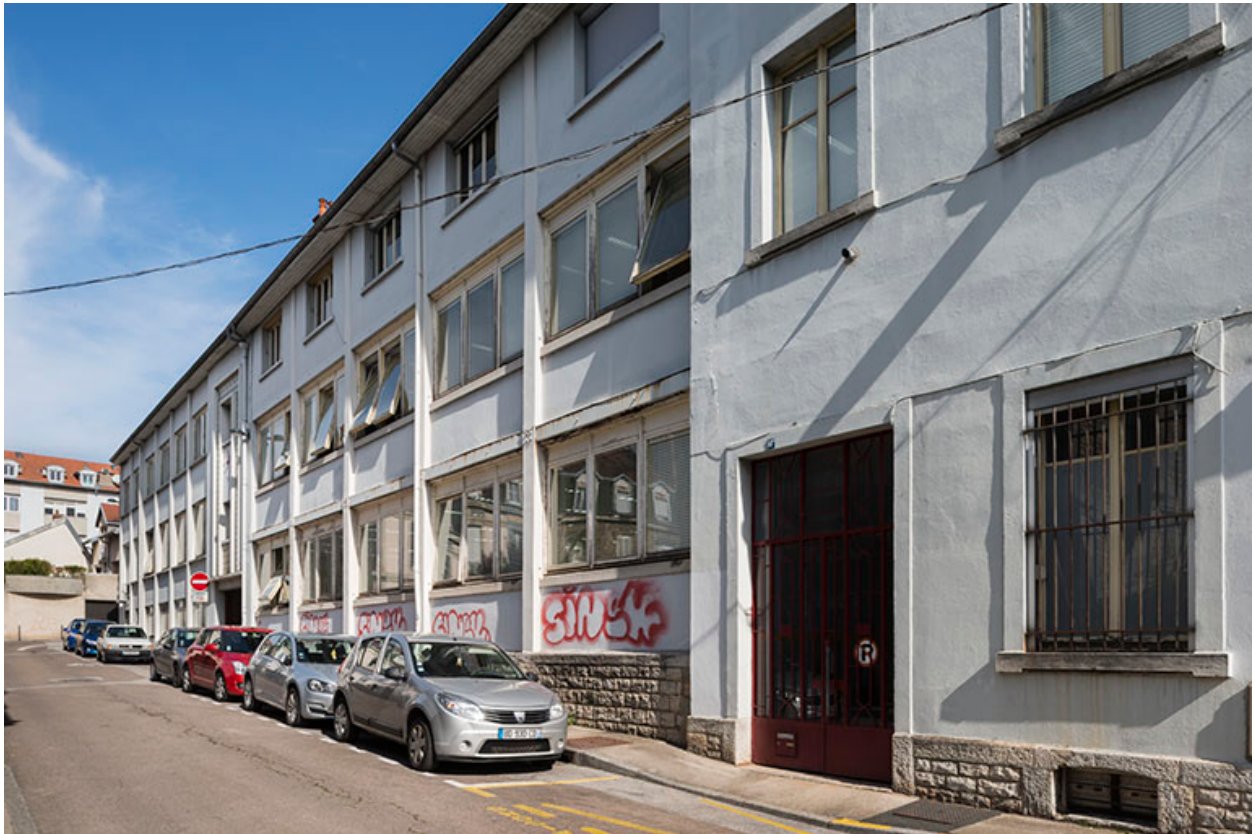
Façade antérieure de l'atelier principal.
