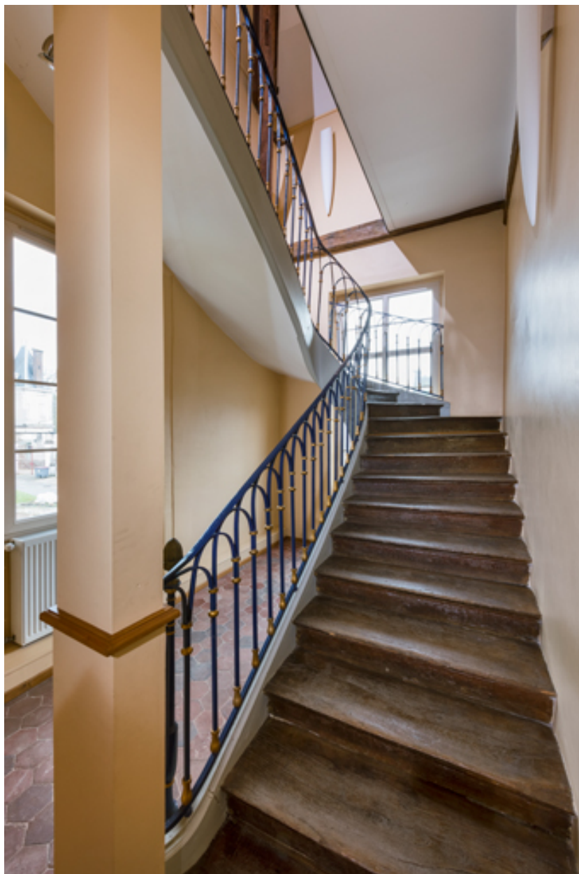
Escalier donnant accès à l'étage en surcroît.
