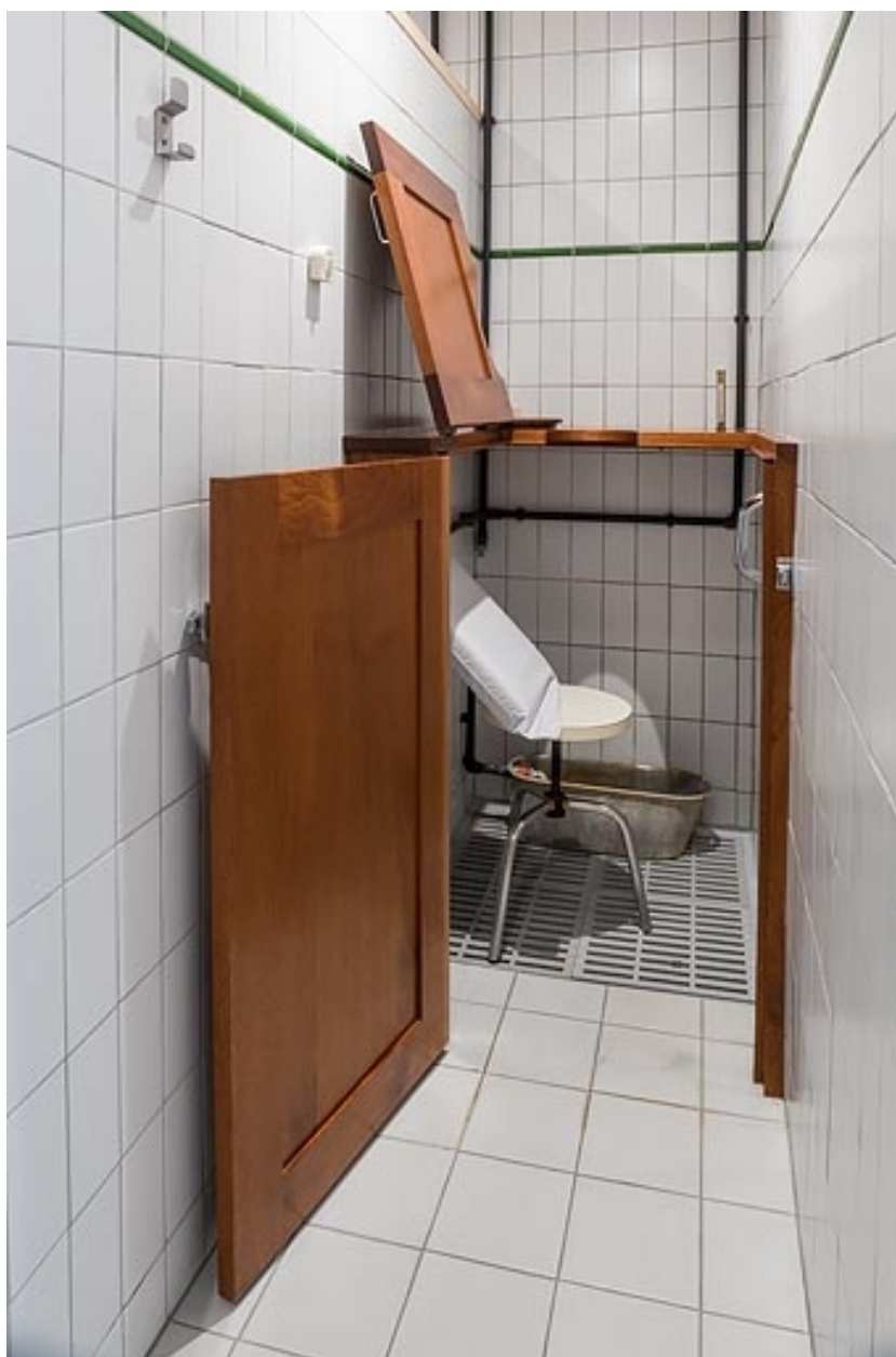
Étuves locales, au rez-de-chaussée (pavillon annexe de 1897).
