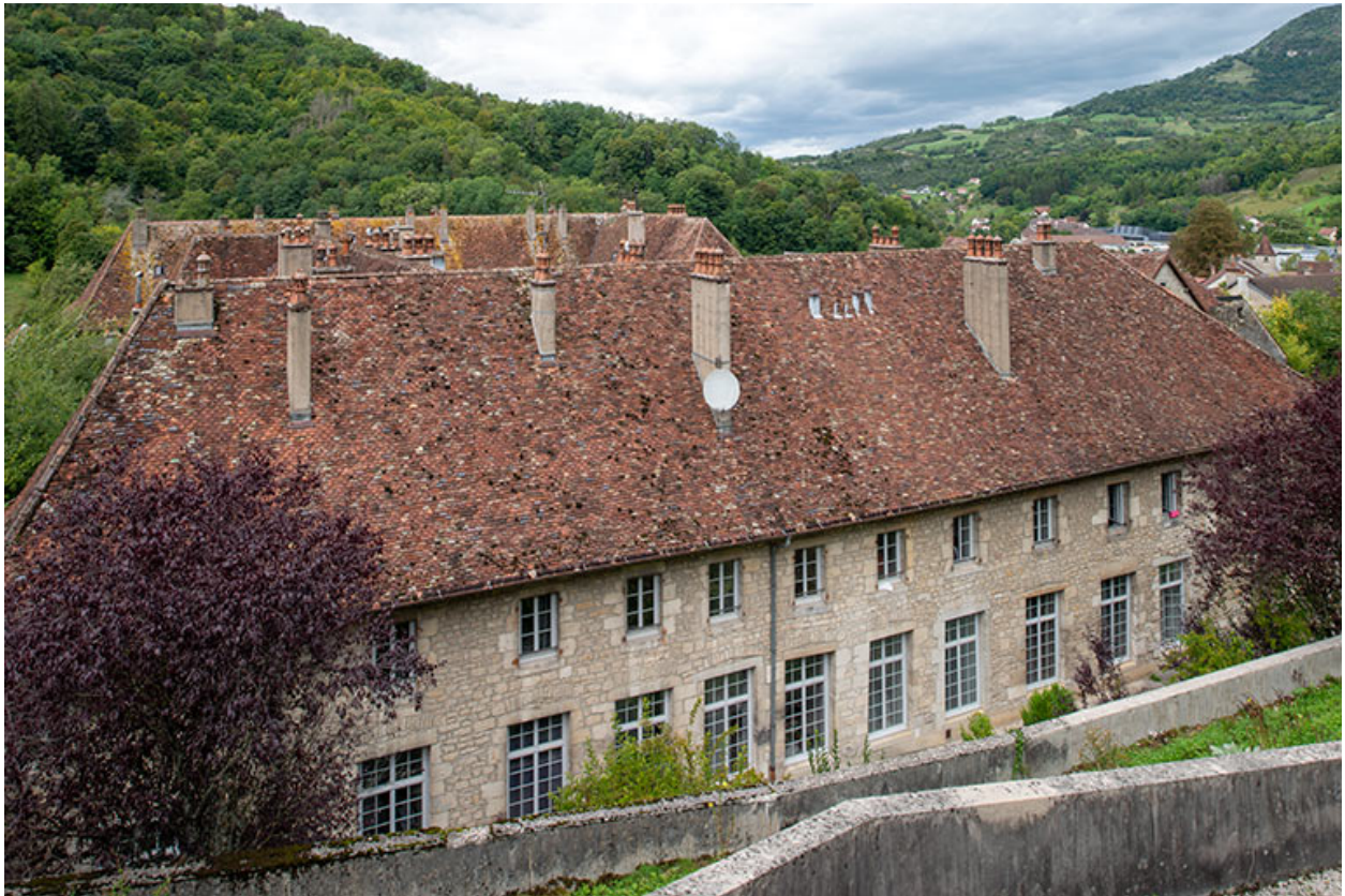
Façade est du bâtiment amont.
