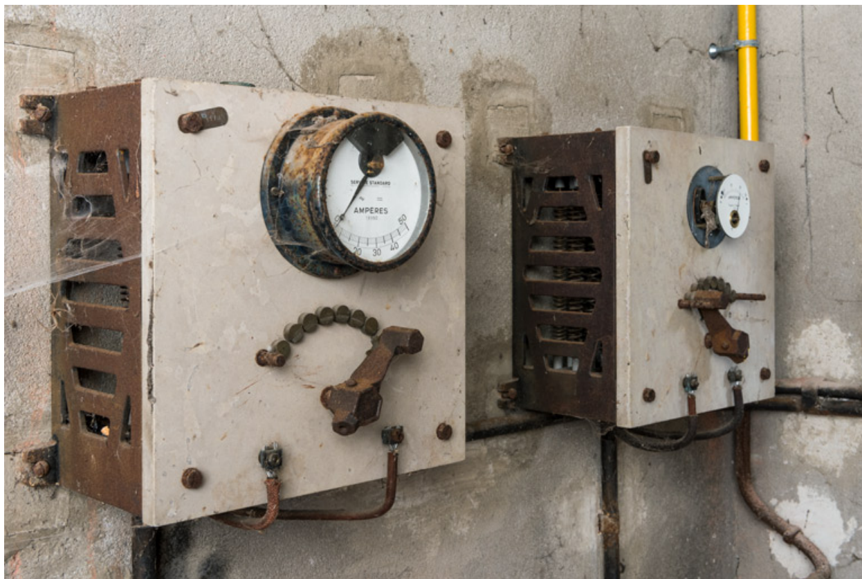
Cabine de projection : rhéostats.
