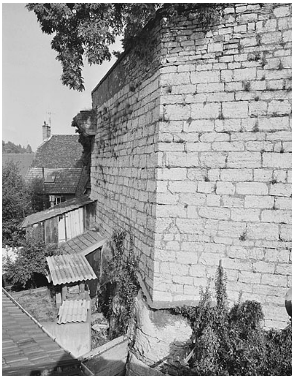
Enceinte. Partie sous le Vieux Château (h).
