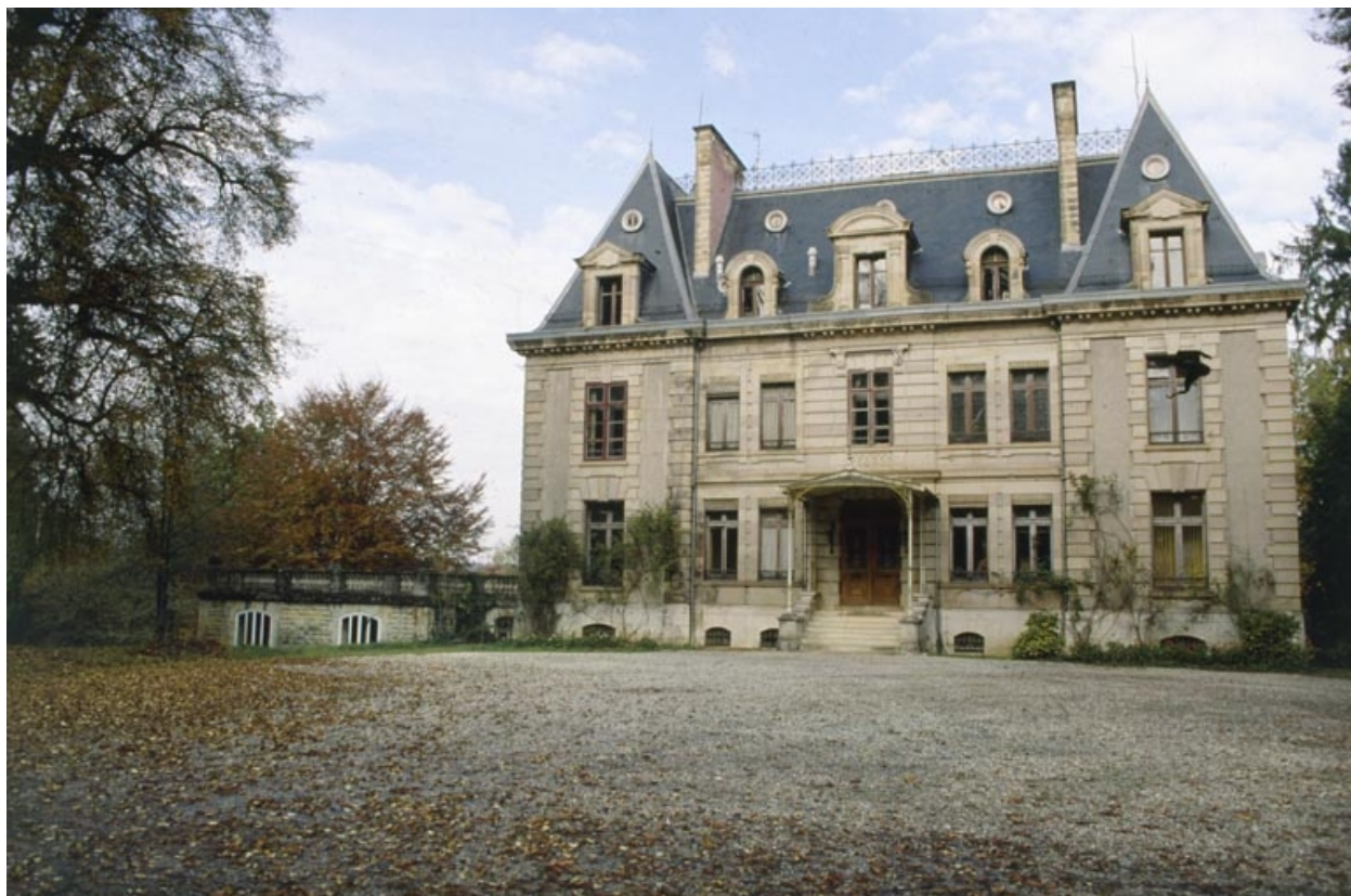
Façade antérieure depuis le sud.
