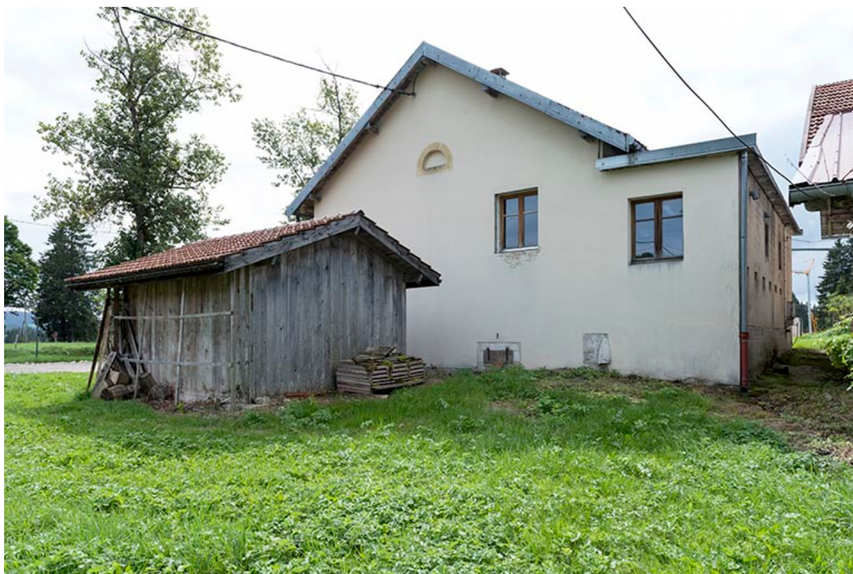
Fromagerie : façade latérale droite.
