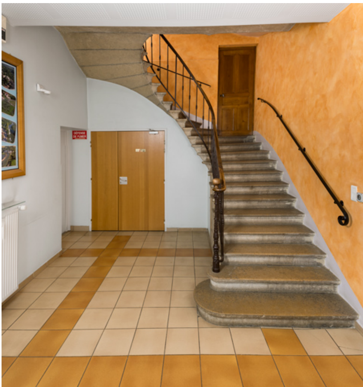
Mairie : vestibule et escalier.
