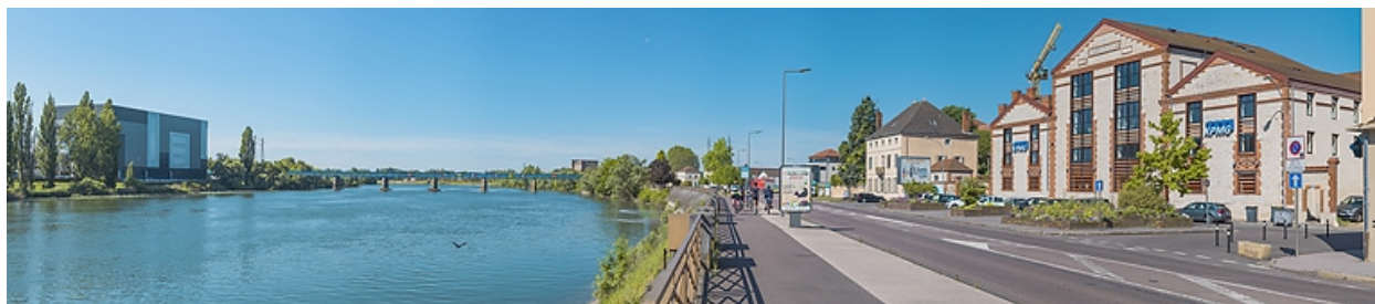
Le quai Saint-Cosme, vu d'amont.
