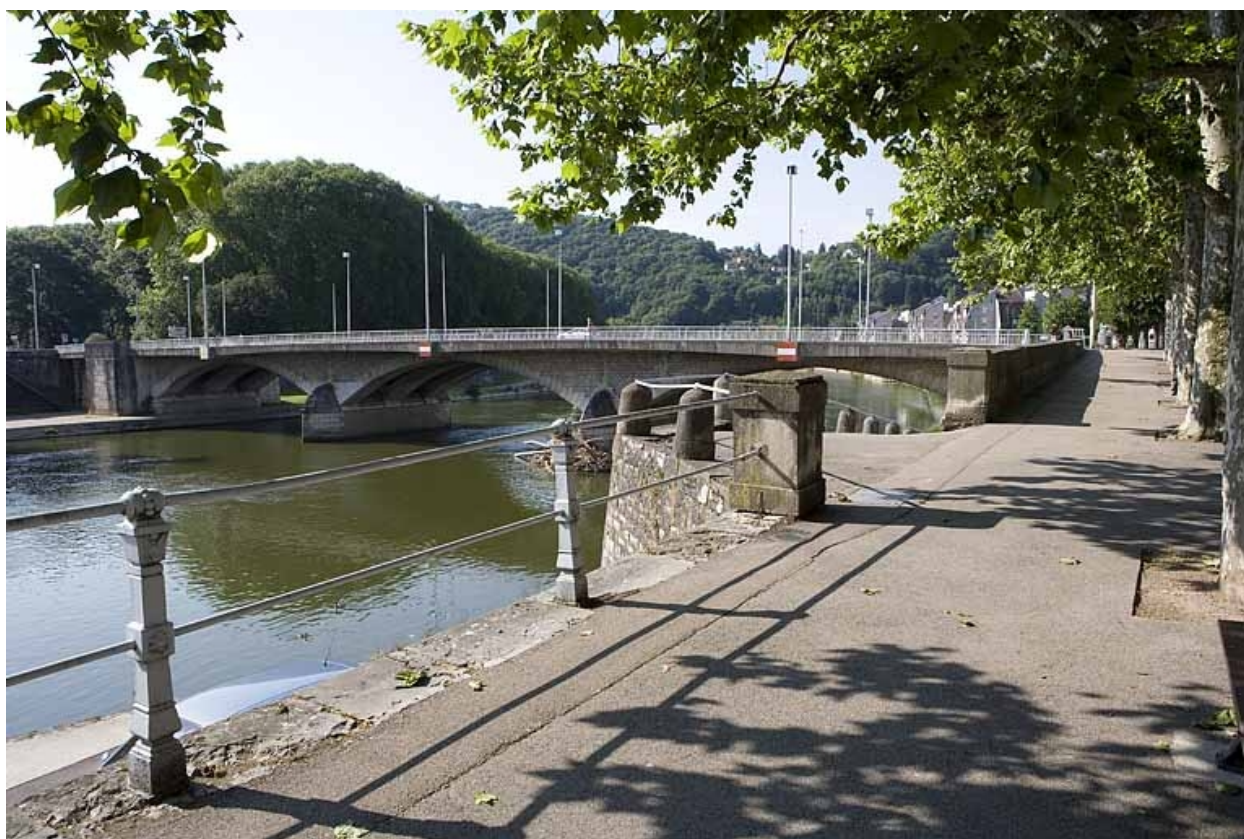
Garde-corps métallique et rampe d'accès au port.
