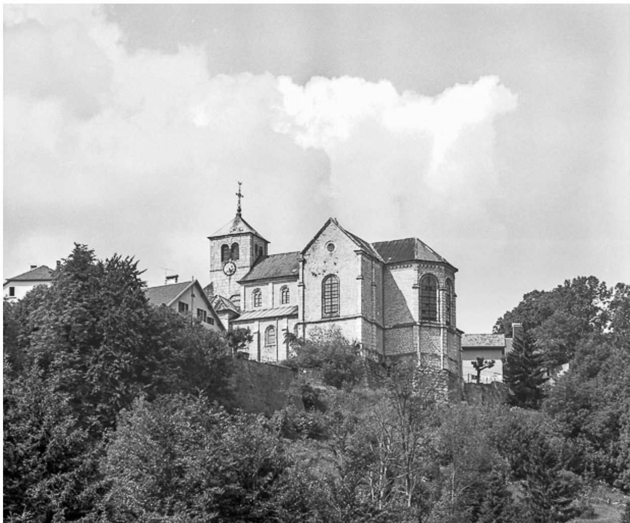
Vue générale depuis le sud en 1979.
