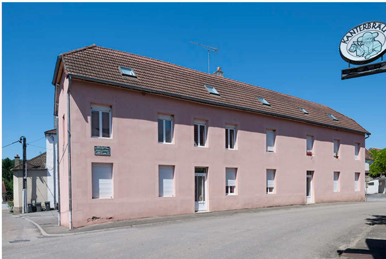
Vue générale de l'édifice.
