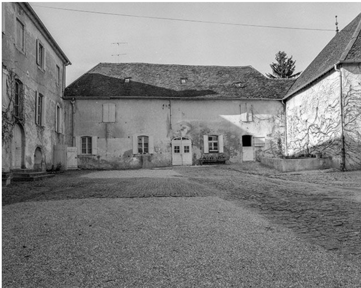
Les communs : façade sur cour.
