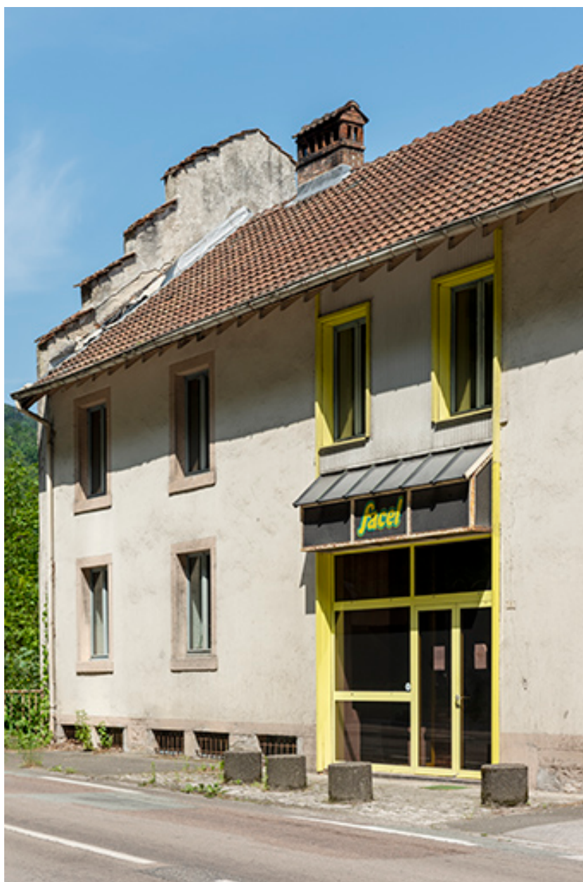
Bureau, façade antérieure : entrée.
