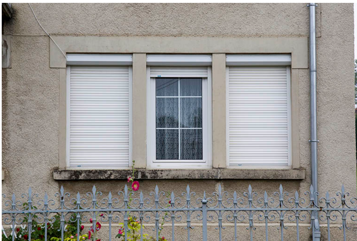
Façade antérieure : fenêtres multiples.
