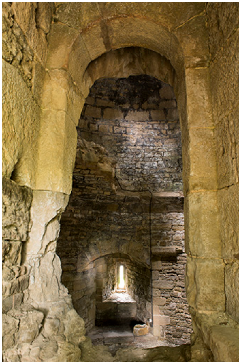
La tour ouest. Vue intérieure depuis l'entrée.
