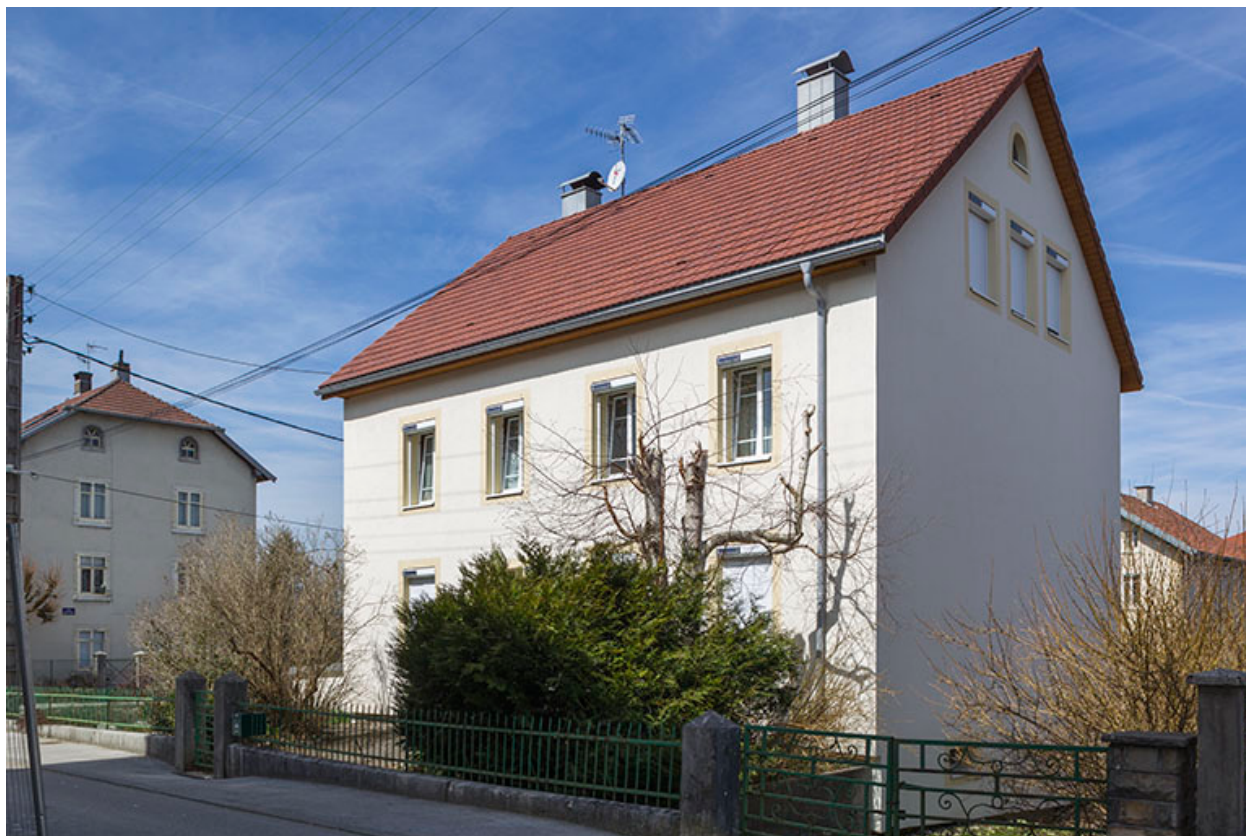
Façades antérieure et latérale droite.
