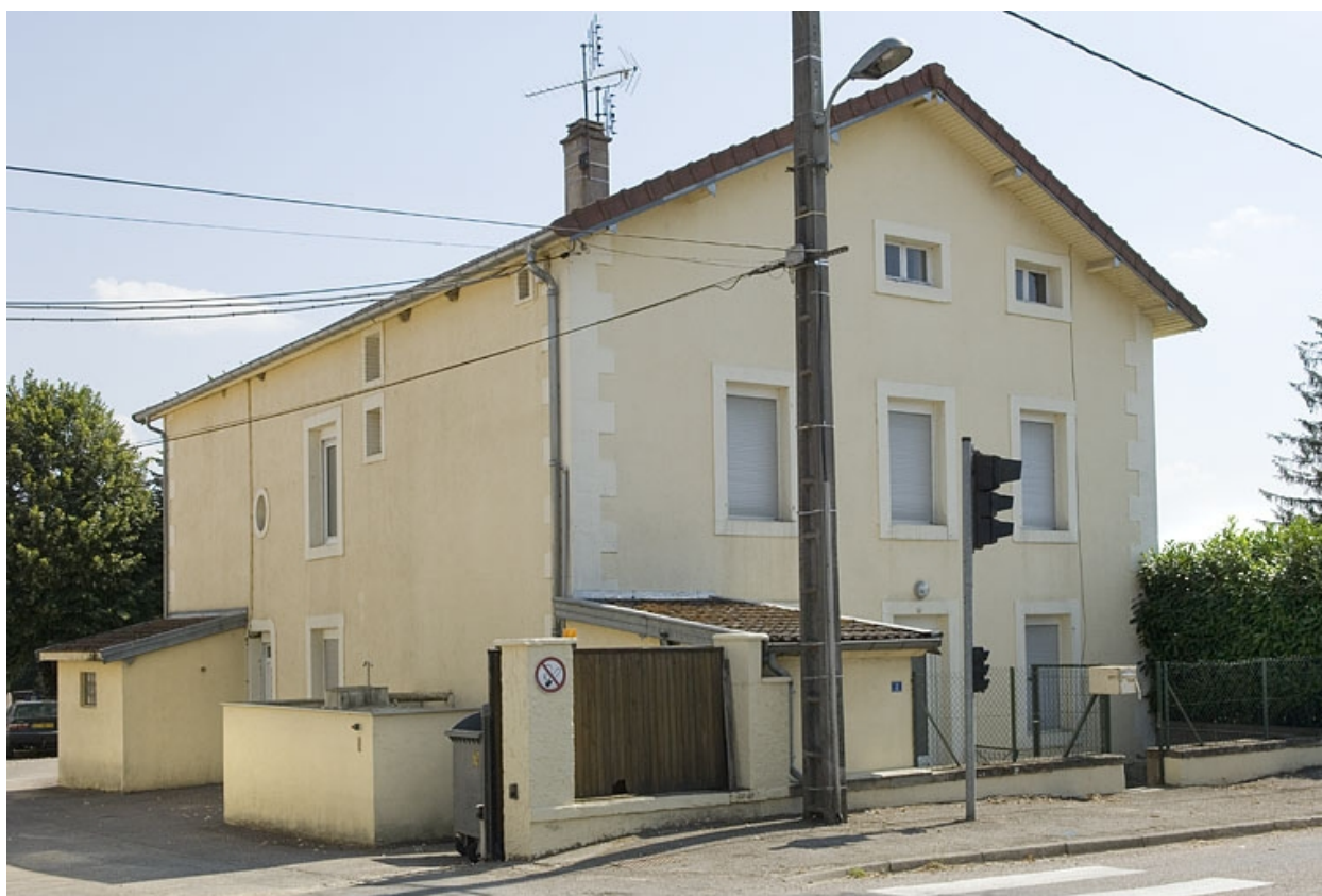
Logement (ancien bureau).
