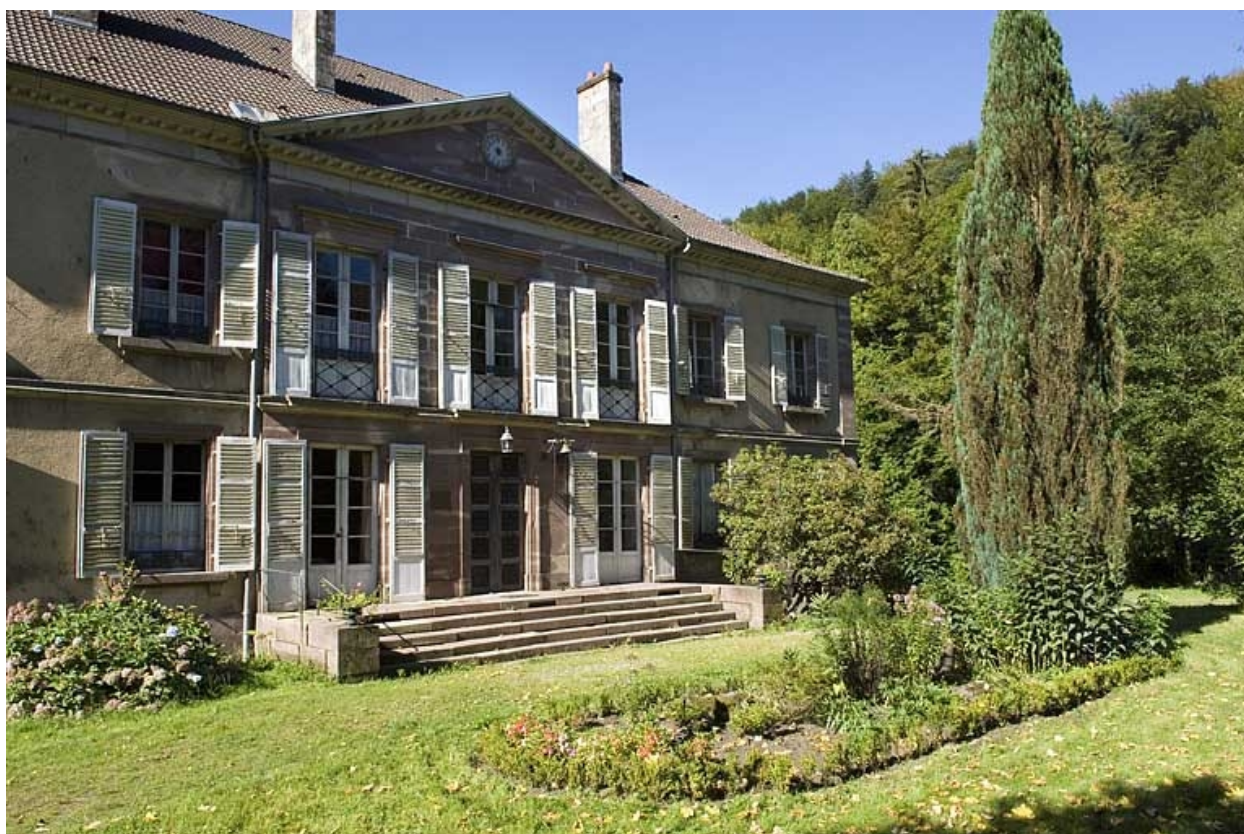
Façade nord vue de trois quarts.
