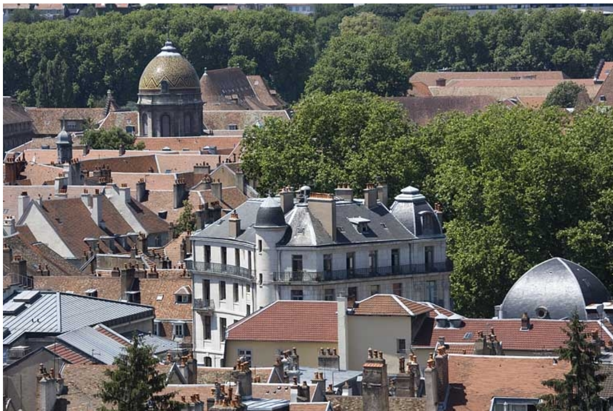
Vue d'ensemble éloignée.
