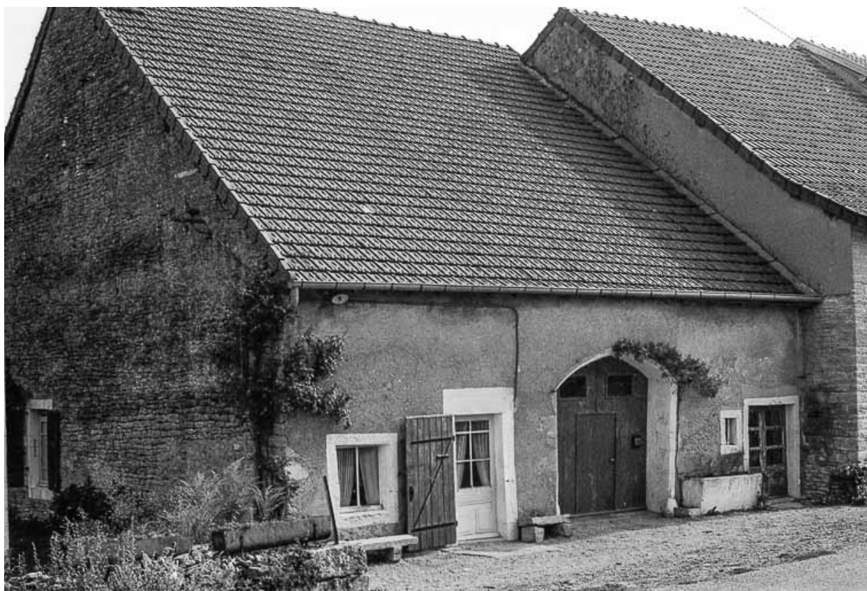
Ferme cadastrée A3 170 : façade antérieure.
