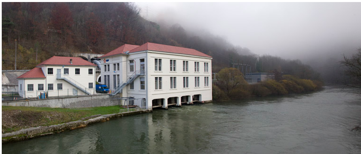
Centrale hydroélectrique de Liebvillers.
