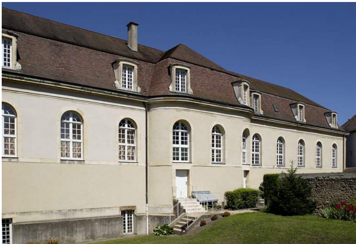
Aile gauche dite fondation Arnault : élévation postérieure.
