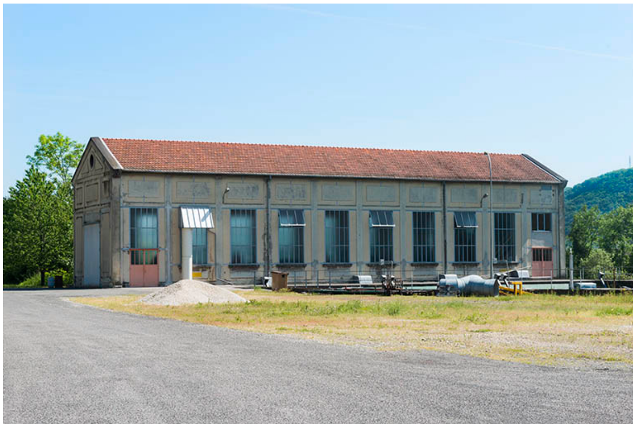
Façade sud de la centrale hydroélectrique.
