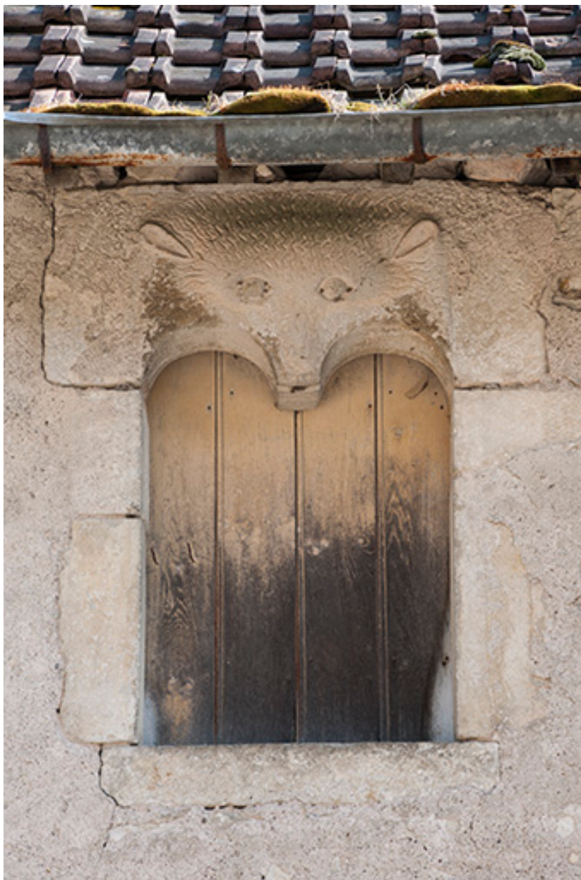
Détail d'une fenêtre du premier étage.
