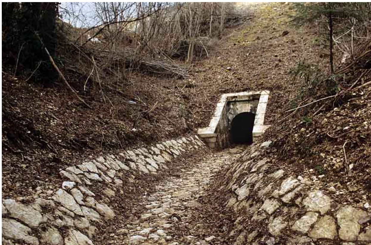
Aqueduc : tête aval et rigole (cadrage horizontal).
