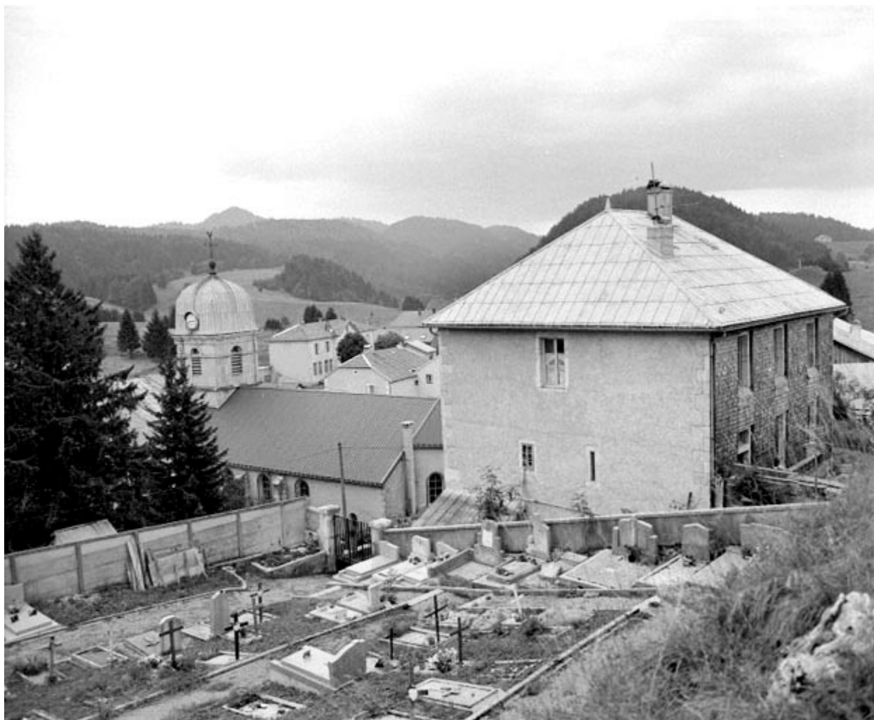
Extérieur : vue de situation depuis le sud-est.
