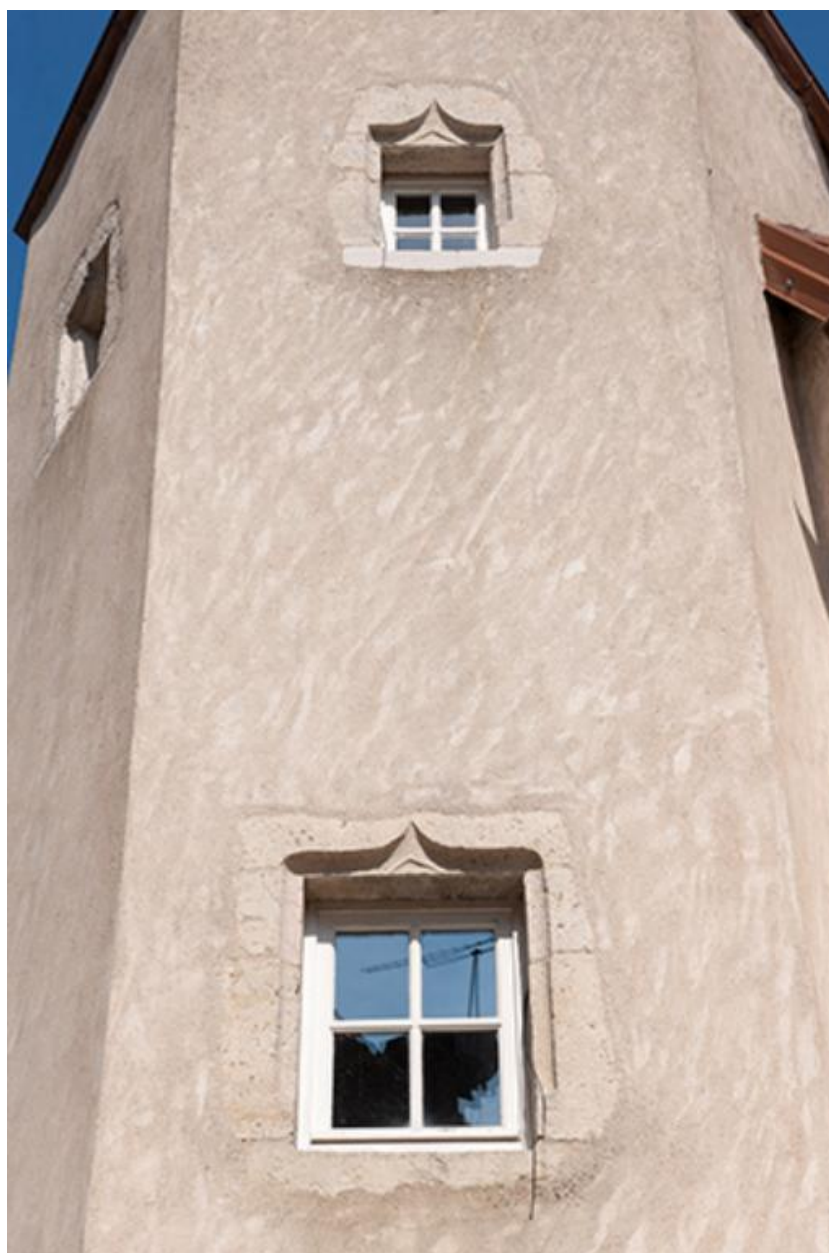
Les baies de la tour d'escalier
