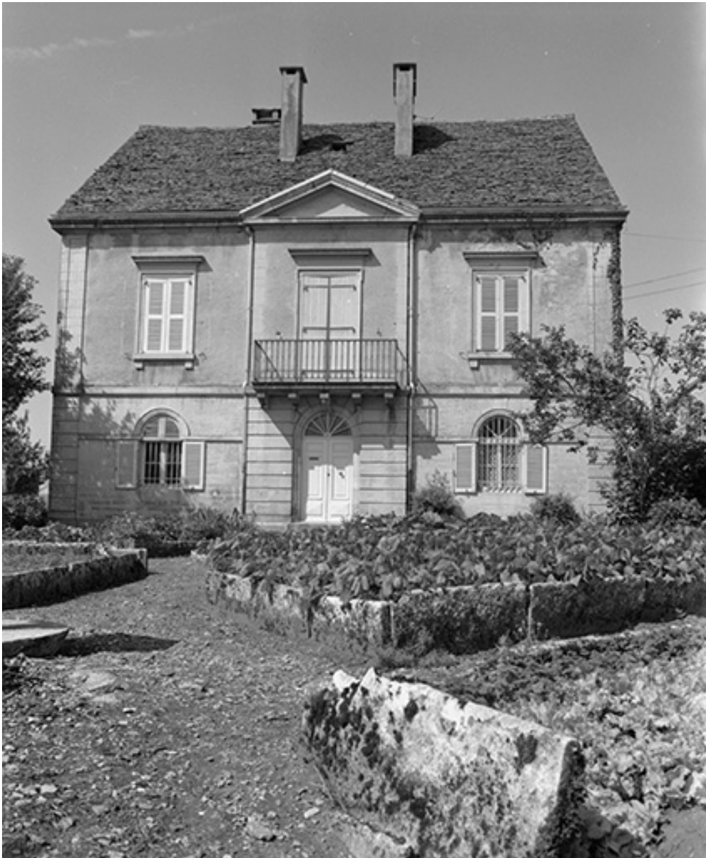
Façade antérieure et jardin.
