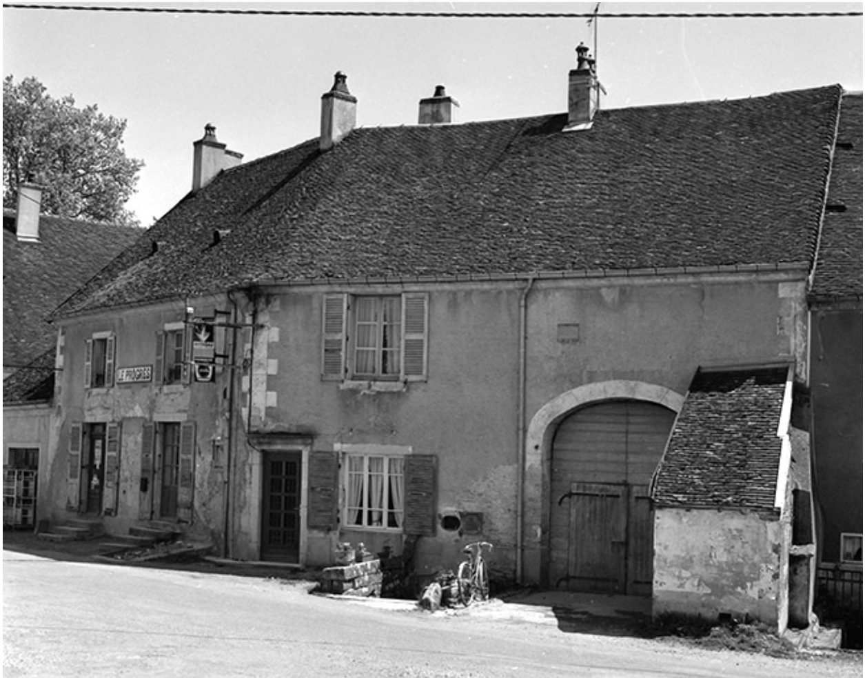
Ferme cadastrée AI 29-30 : façade antérieure, vue rapprochée.
