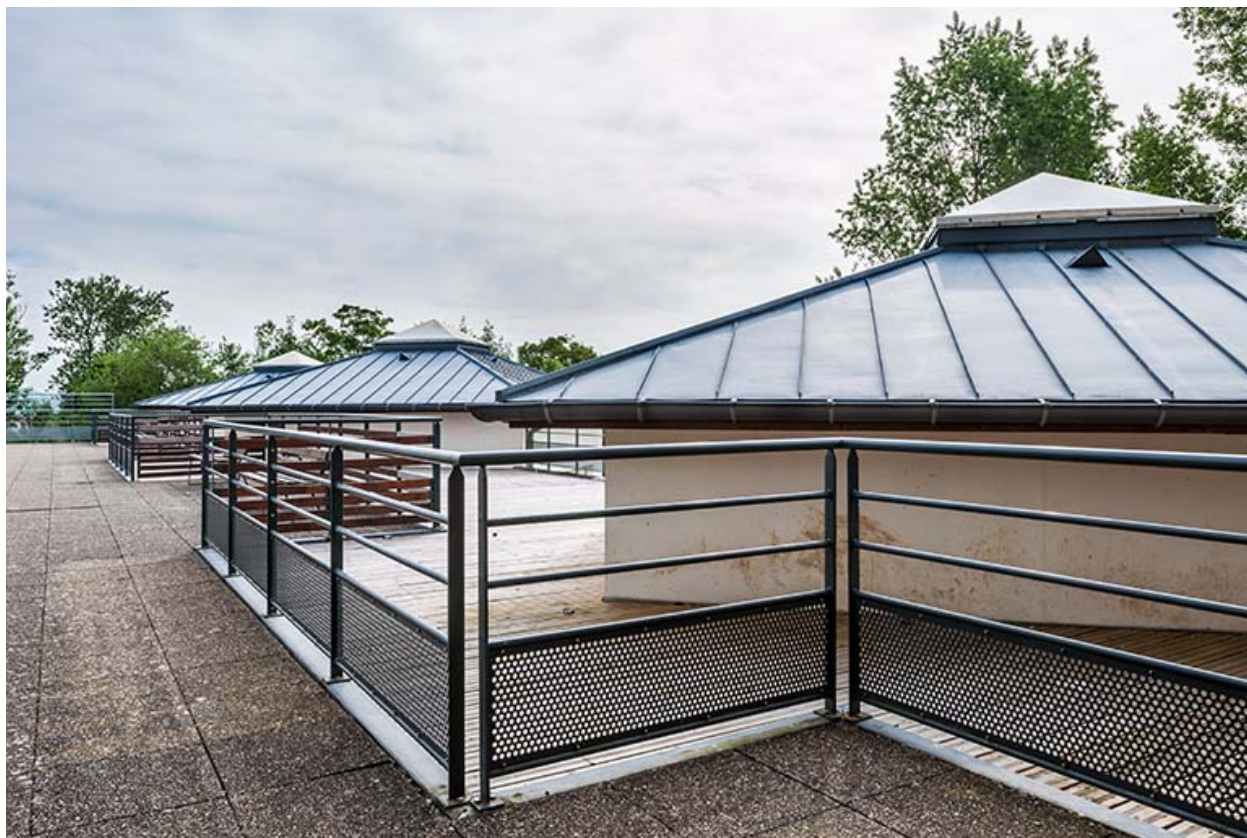
Terrasse et toiture des ateliers.
