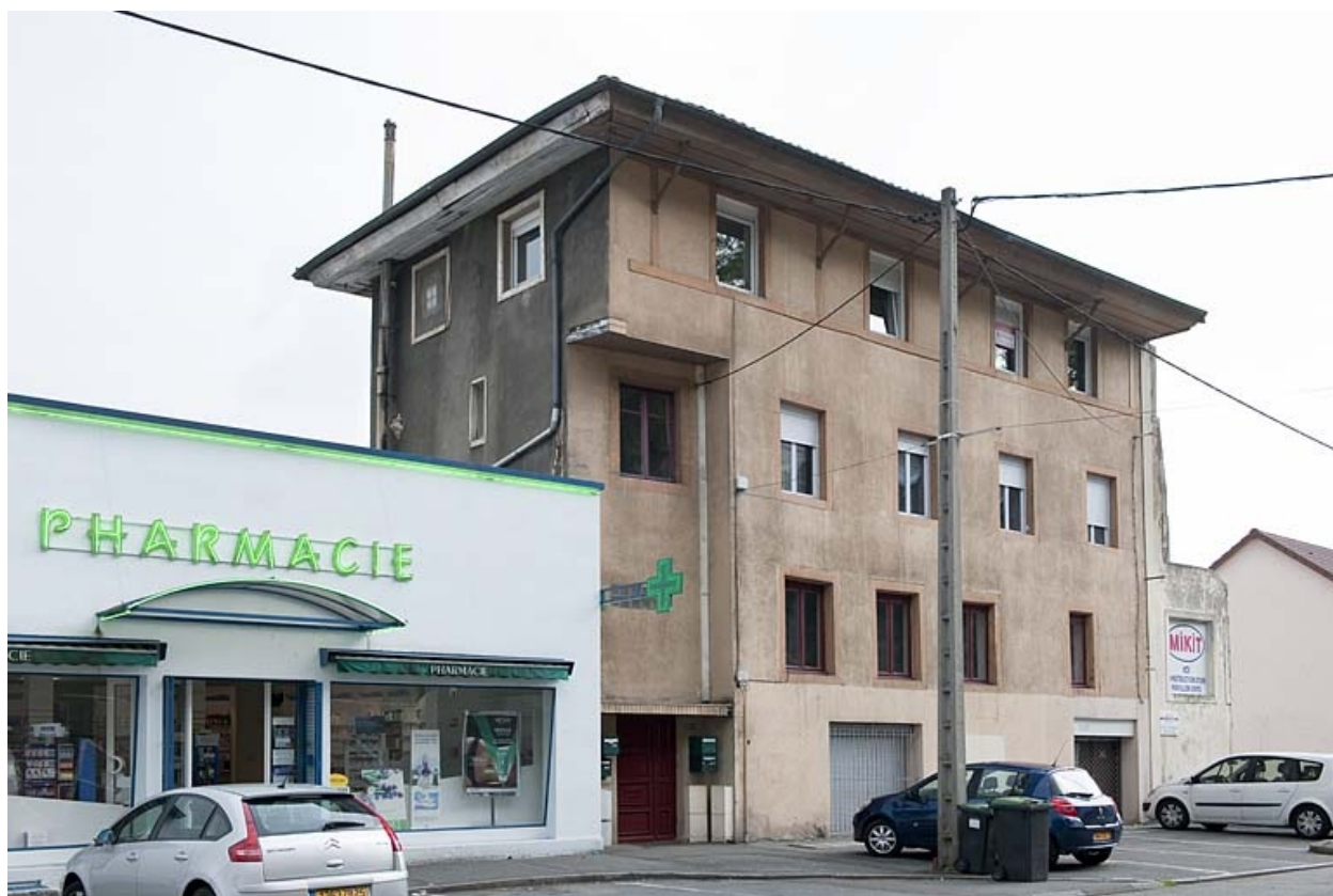
Vestiges de l'atelier depuis la rue.
