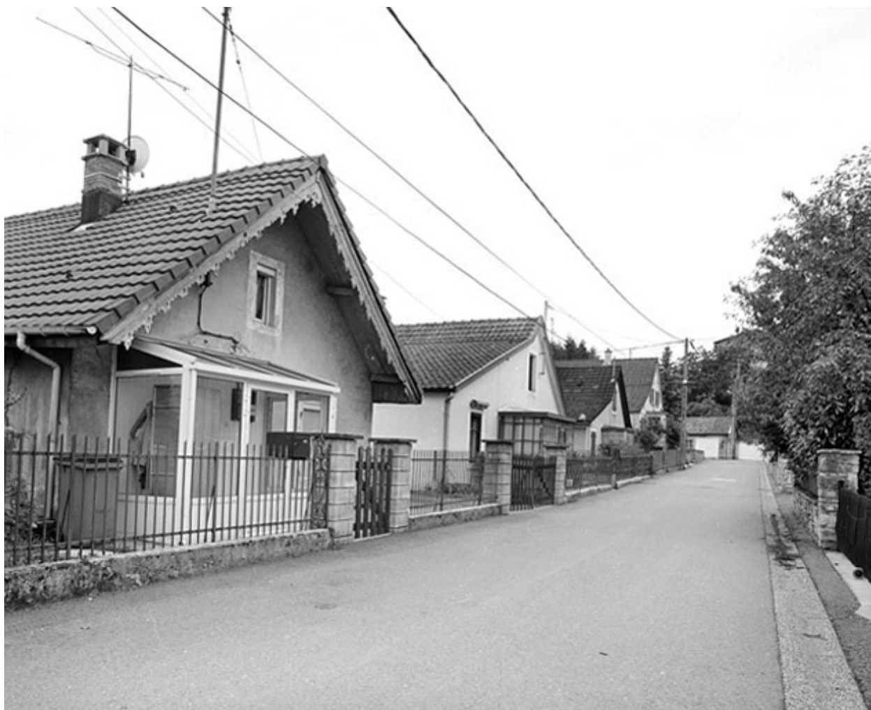
Alignement de maisons rue du Temple.
