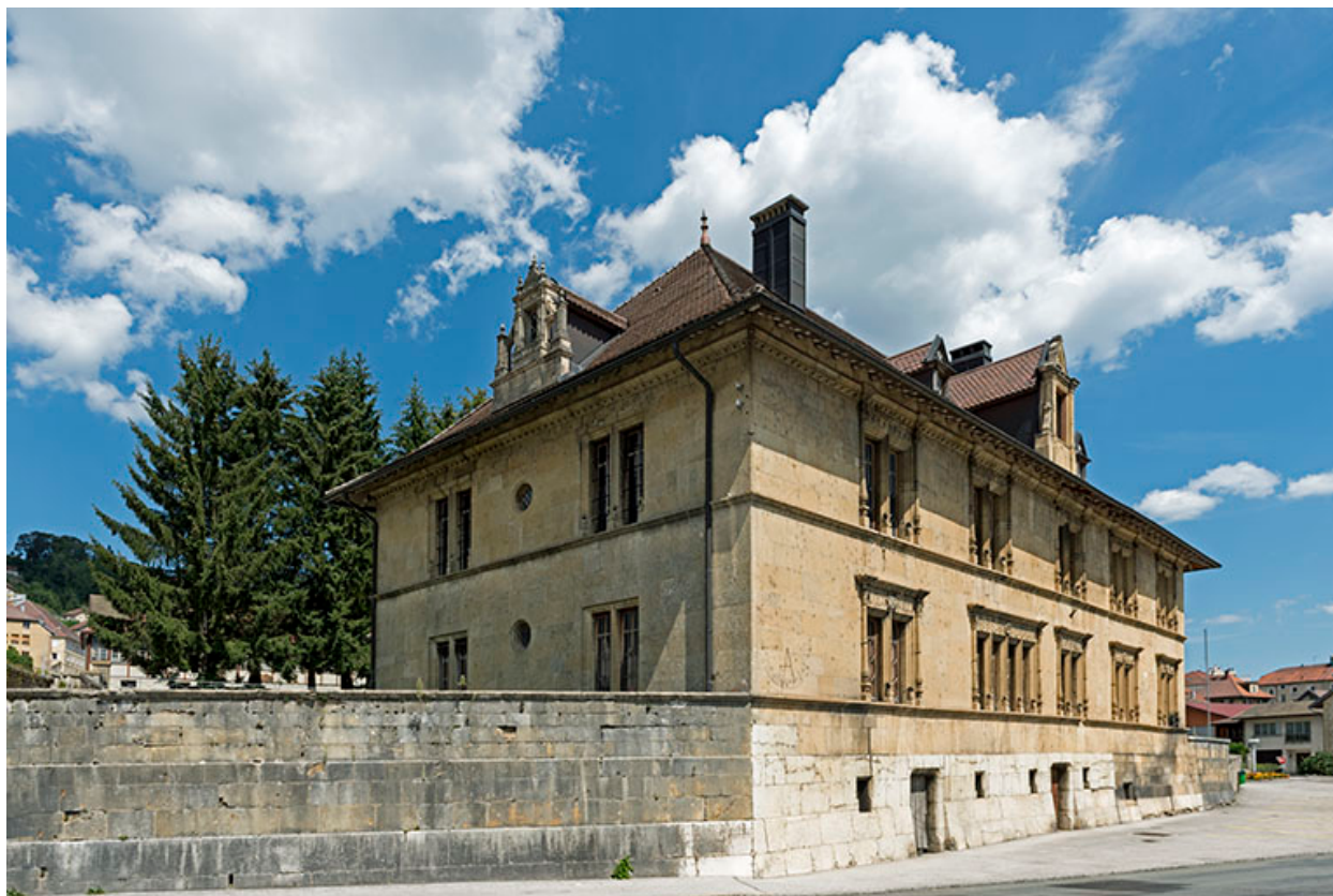
Vue d'ensemble depuis la rue, au sud.
