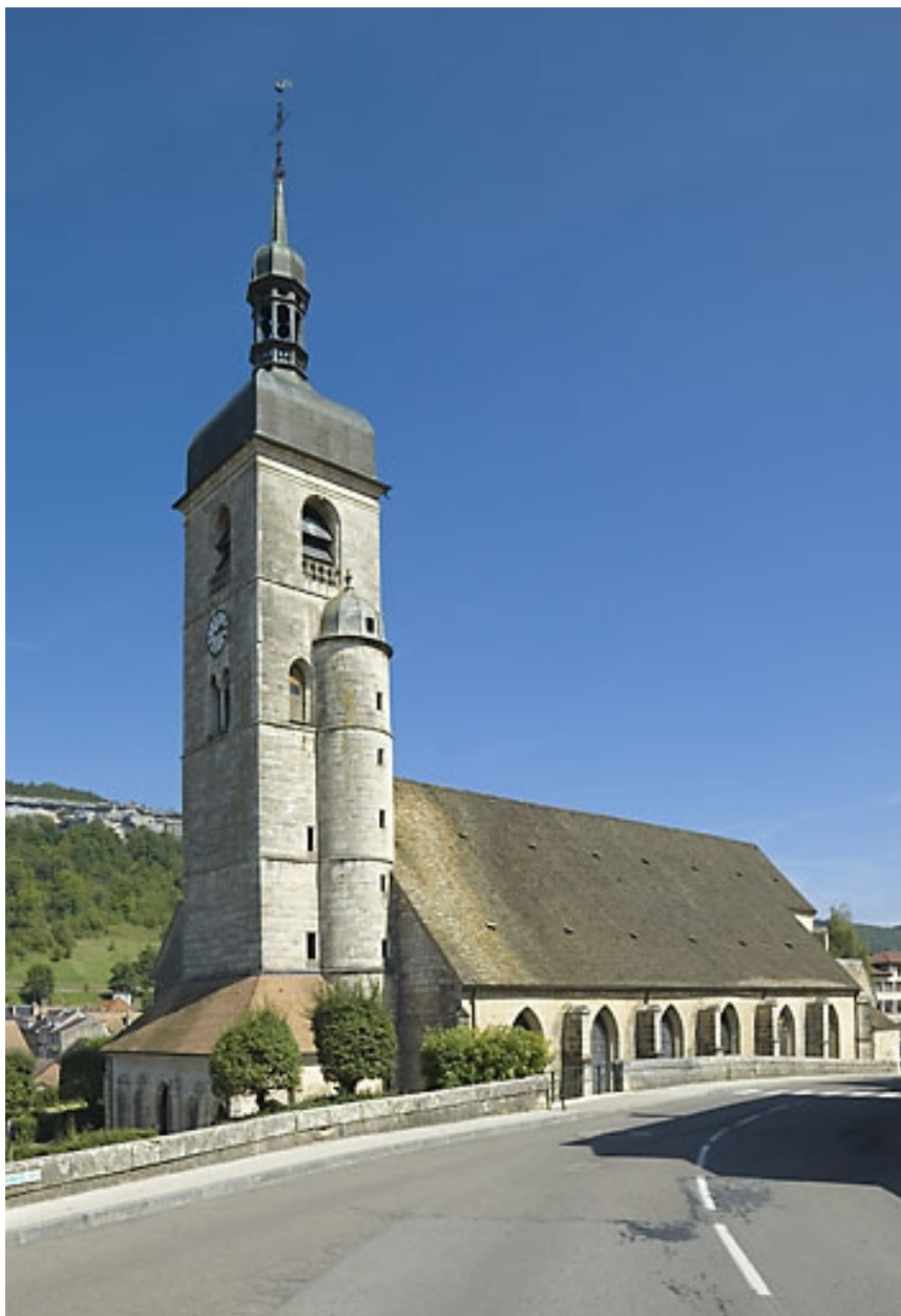
Vue de la tour-clocher.
