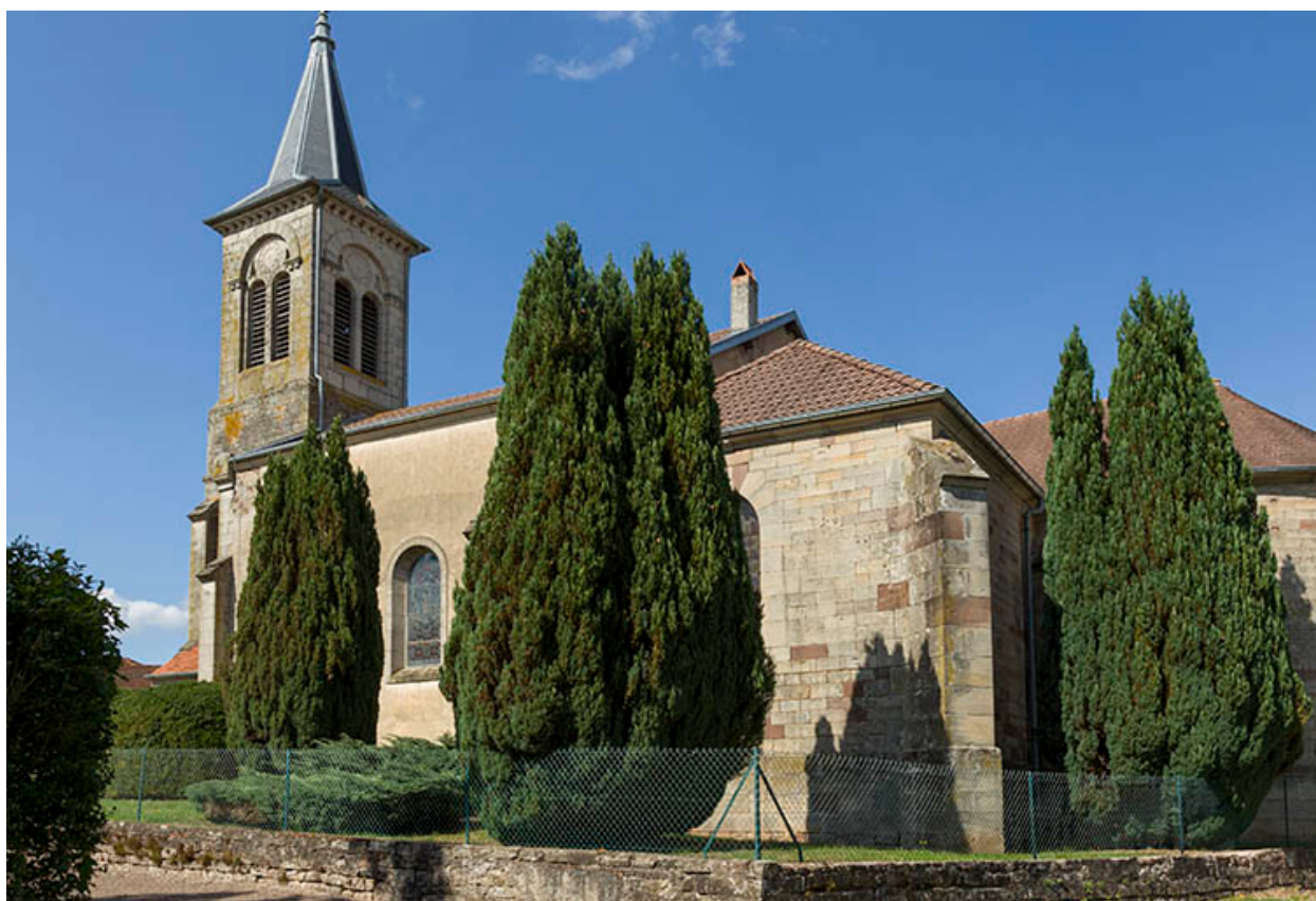
Façade latérale sud de la nef.
