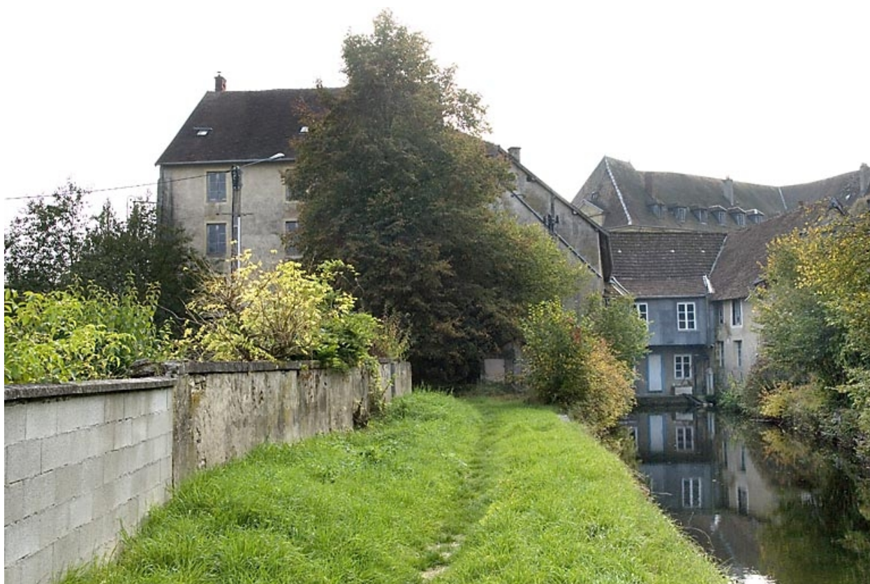
Façade postérieure depuis l'amont du bief.
