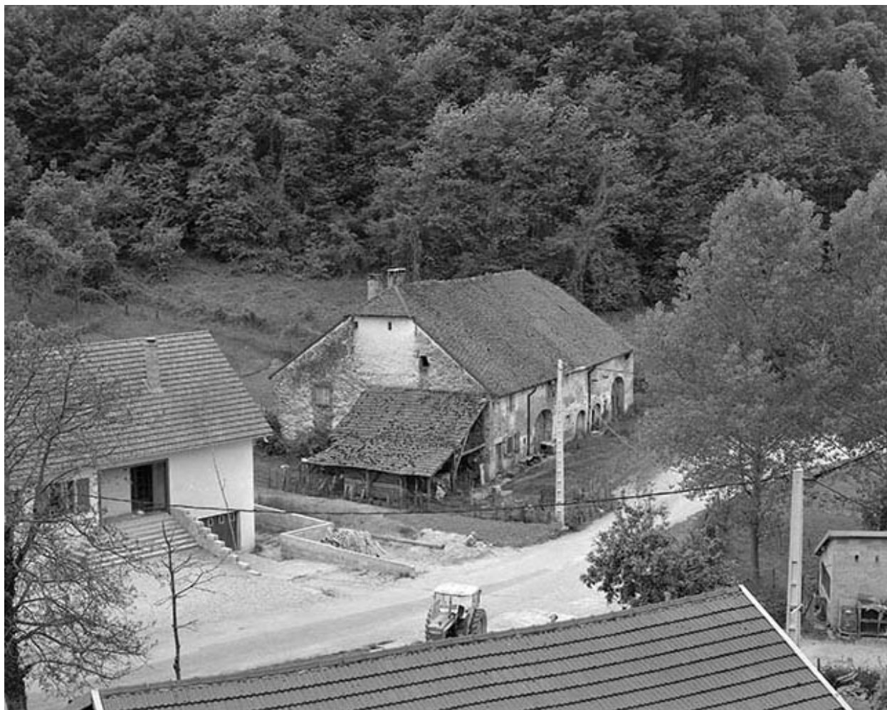
Ferme située rue Saint-Vincent : vue d'ensemble.
