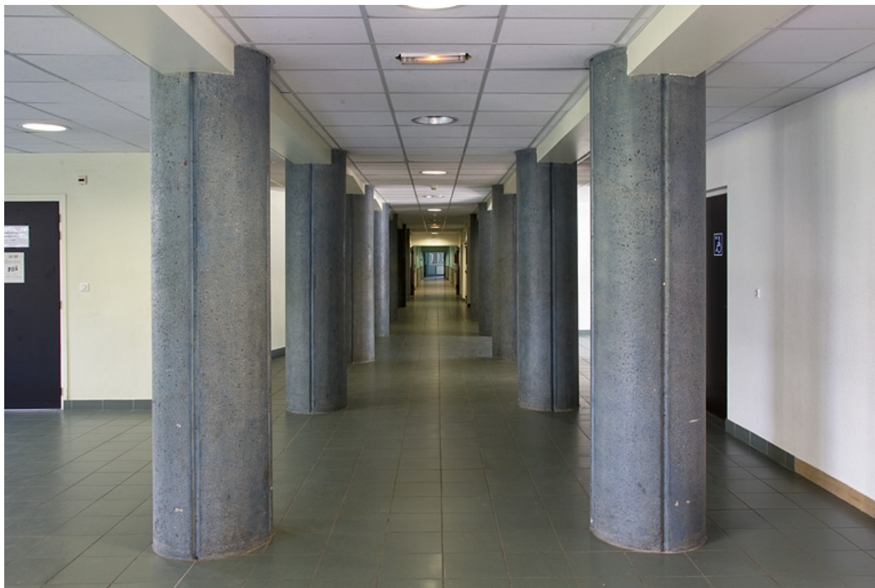
Bâtiment de l'infirmerie : colonnes.
