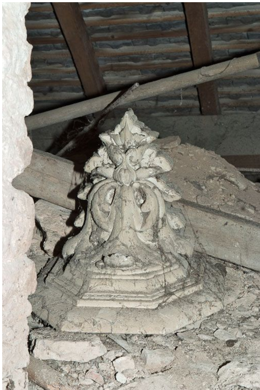
Vue d'ensemble d'une console.
