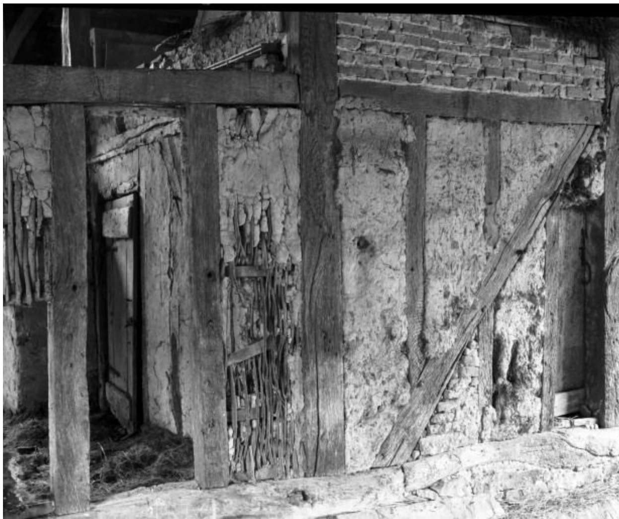
Aire de battage, détail du mur droit.
