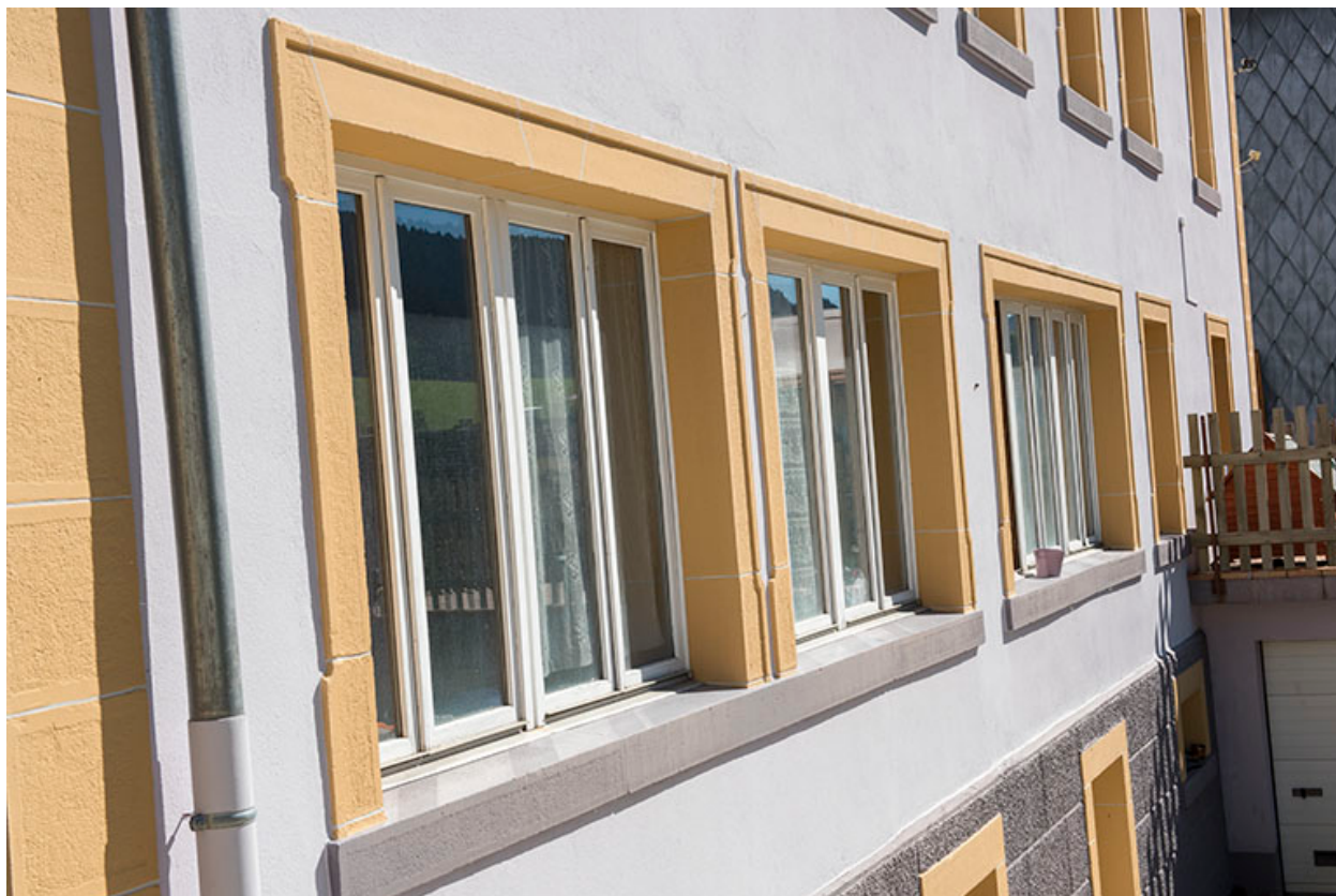
Façade postérieure : baies d'atelier vues en enfilade.
