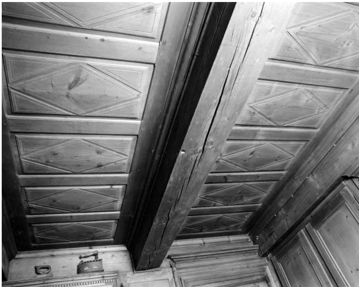
Intérieur : le "poêle", plafond.
