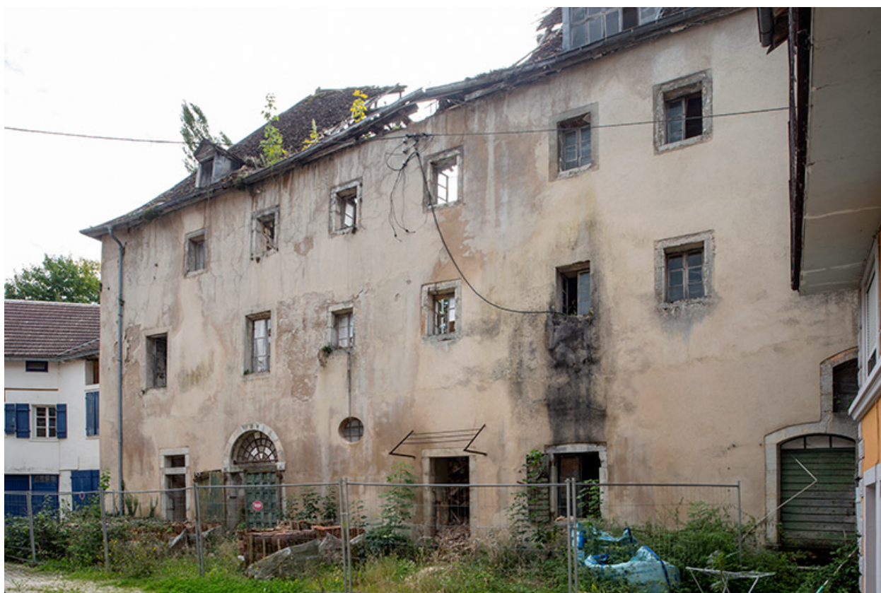
Façade nord du grand bâtiment conventuel.
