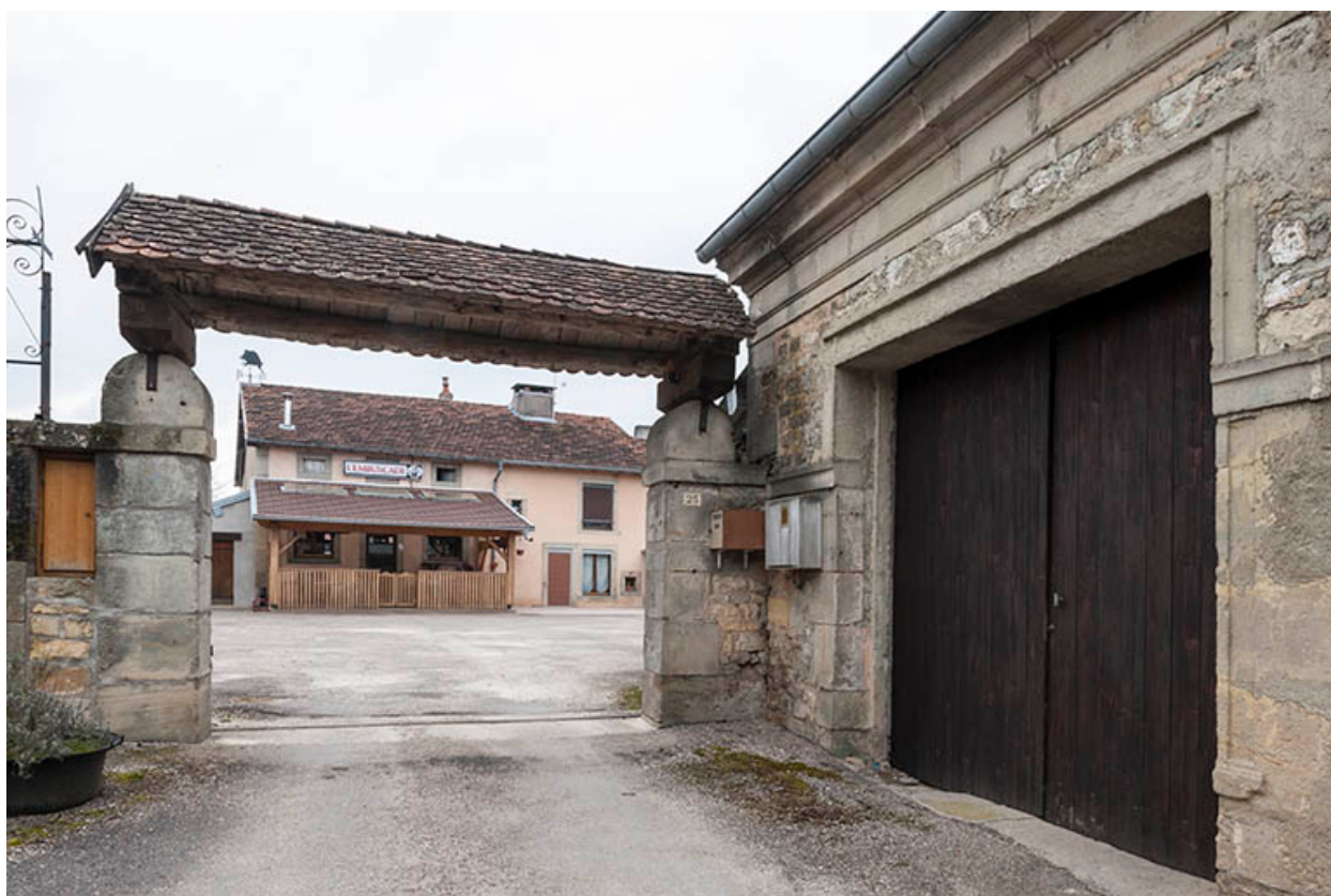
Ancienne maison des soeur.
